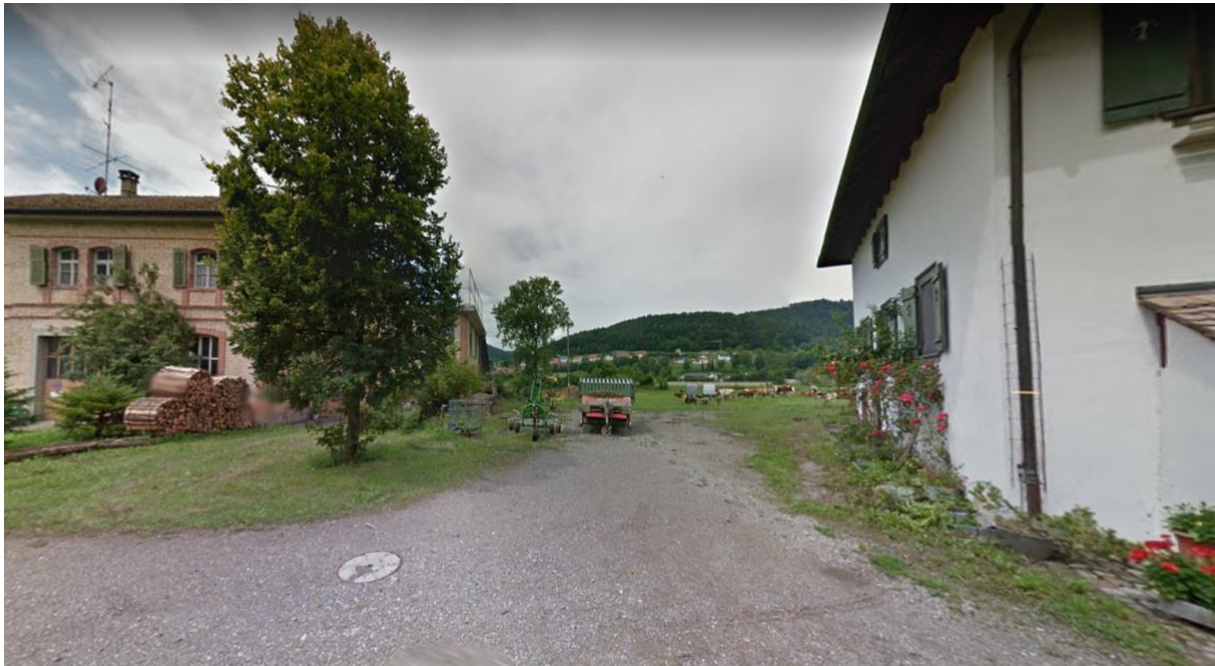
ANSICHT VORNE: RECHTS DAS TURBINENHAUS; LINKS DAS RESTAURANT MÜHLE
